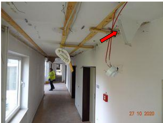
F 055 + 056: Geb. 55 T1 EG, Abgehängte Deckenplatten aus Flur ( 2 Stück, Probe P11 ( asbestfrei )
