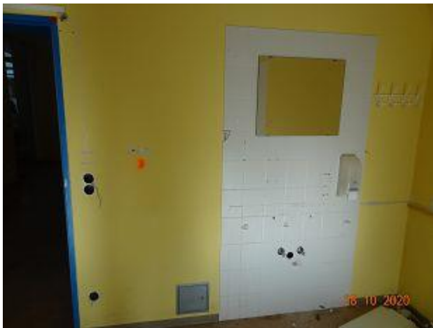
F 077 + 078: Geb. 55 T3 A + B, Wandfliesenkleber, Probe P23 ( asbestfrei )
