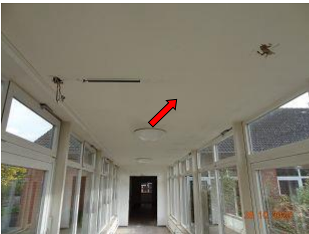
F 082 + 083: Abgehängte Decken mit KMF Auflage
