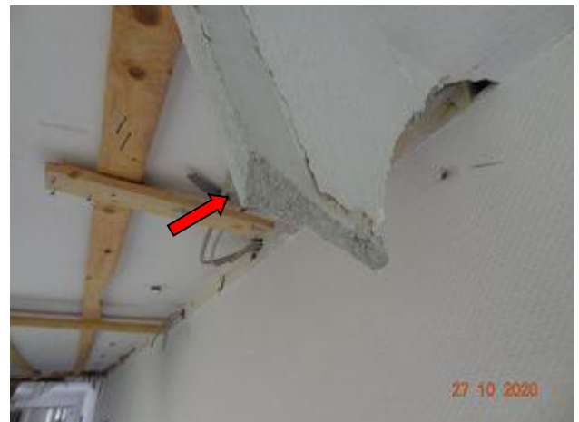
F 055 + 056: Geb. 55 T1 EG, Abgehängte Deckenplatten aus Flur ( 2 Stück, Probe P11 ( asbestfrei )
