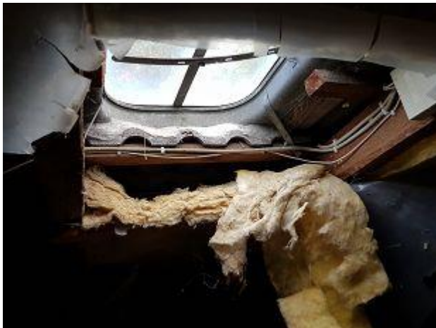
F 634 + 659: Lose KMF Isolierungen im gesamten Gebäude
