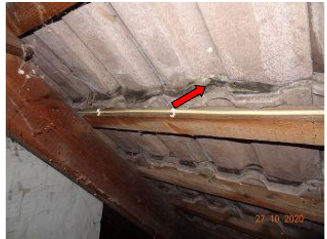
F 040: Dachpfannen gedämmt mit KMF Dämmung
