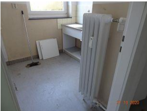
F 026: Geb. 55 A EG, Bodenbelag + Kleber aus Küche, Probe P7 ( asbestfrei )
