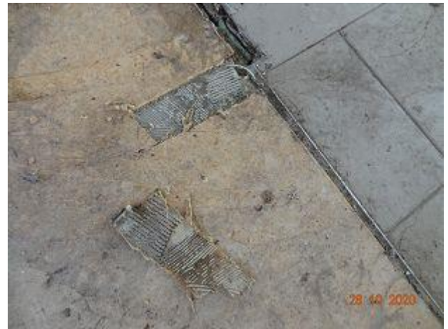
F 075 + 076: Geb. 55 T3 A, Bodenbelag + Kleber aus Flur, Probe P22 ( asbestfrei ) Rundstütze mit AZ- Schale MP 13
