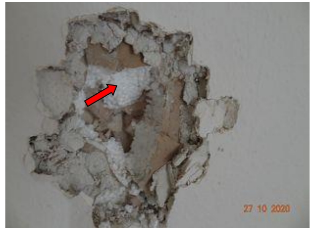
F 065 + 066: Styropor Dämmung in Leichtbauwänden aus R. 020, Probe P13
