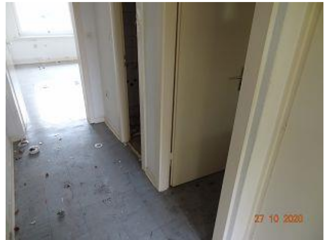
F 037 + 038: Floorflexbodenbeläge teils ganzflächig, teils unter neuem Lino Belag
