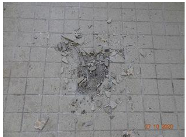
F 027 + 028: Geb. 55 A EG, Bodenfliesenkleber aus WC, Probe P8 ( Chrysotilasbest )
