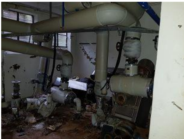
F 837: Rohrleitungen mit KMF so wie lose KMF im KG
