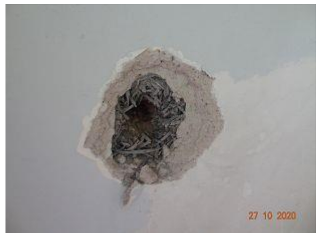
F 050 + 051: Außenfassade mit HWL-Platten, ohne KMF
