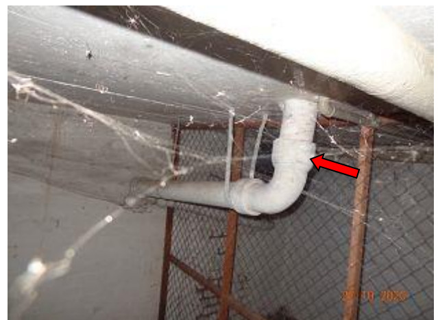
F 030 + 031: AZ- Abwasserrohre
