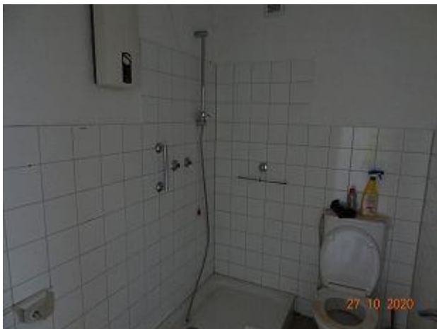
F 013 + 014: Geb. 55 A EG, Wandfliesenkleber aus Bad, Probe P4 ( asbestfrei )
