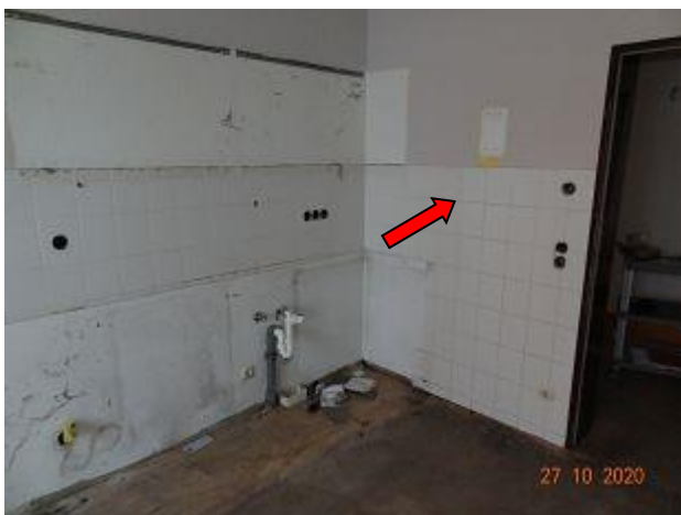
F 068: Geb. 55 T2 EG, Wandfliesenkleber aus R. 0.02, Probe P15 ( asbestfrei )
