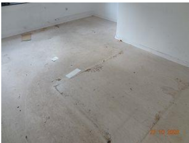
F 015 + 020: Geb. 55 A EG, Bodenbelag Beige + Kleber aus Wohnraum, Probe P5 ( Chrysotilasbest in Schwarzanzhaftung )
