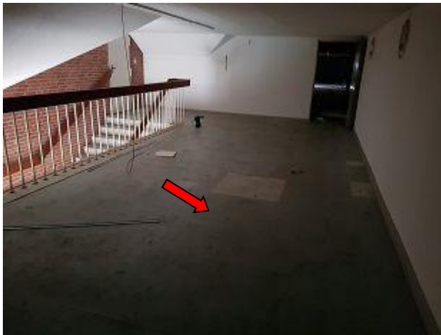
F 008 + 021: Zugang zum DG mit Floorflexplatten ( Belag und Kleber asbesthaltig )
