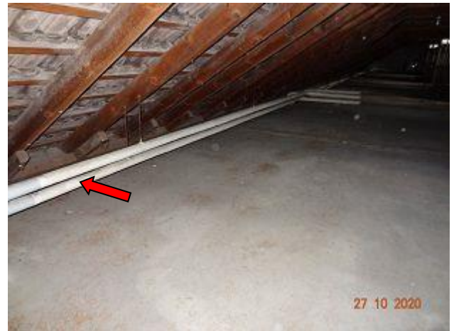
F 029 + 041: Rohrleitungen mit KMF im DG
