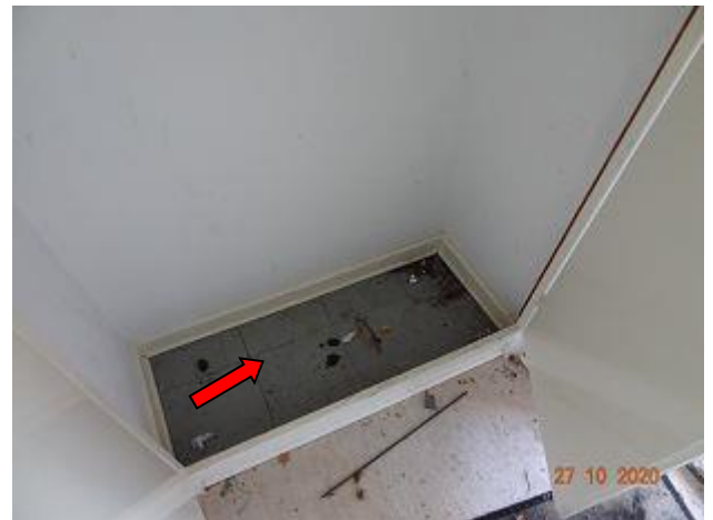
F 005 + 009: Geb. 55 A EG, Bodenbelag + Kleber aus Schrankbereich, Probe P2 ( Chrysotilasbest )
