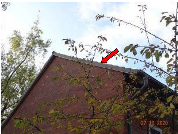
F 003 + 004: Giebel / Dachrandverkleidungen ggf. AZ
