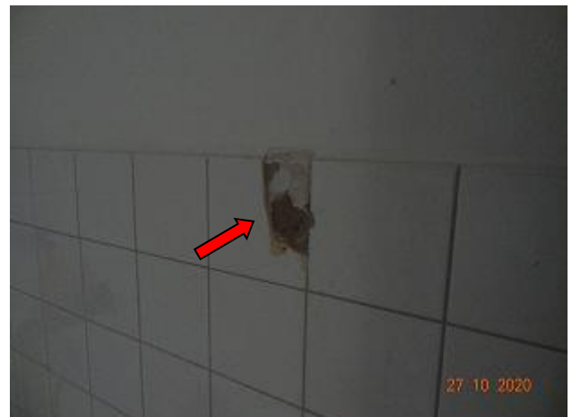
F 013 + 014: Geb. 55 A EG, Wandfliesenkleber aus Bad, Probe P4 ( asbestfrei )
