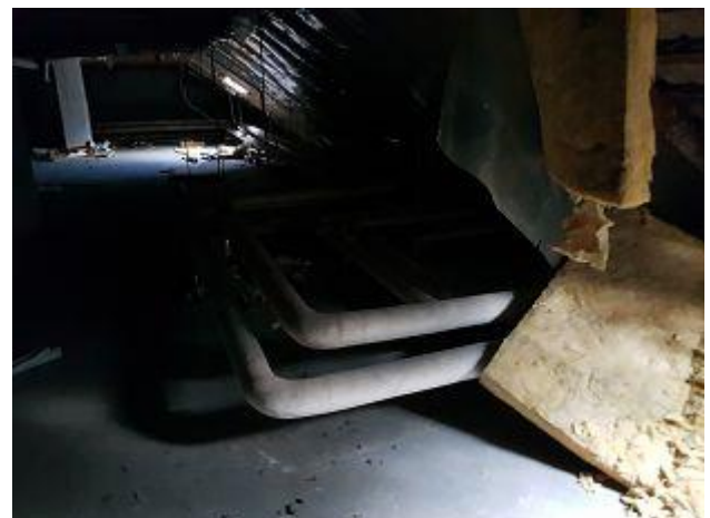
F 642: Rohrleitungen mit KMF
