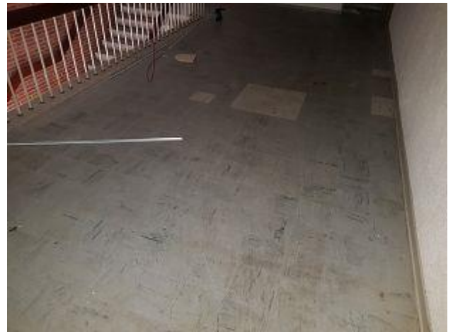
F 008 + 021: Zugang zum DG mit Floorflexplatten ( Belag und Kleber asbesthaltig )
