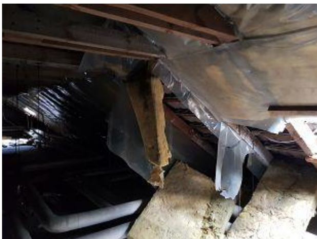
F 639: Dachpfannen gedämmt mit KMF
