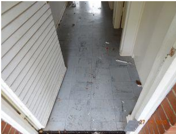
F 037 + 038: Floorflexbodenbeläge teils ganzflächig, teils unter neuem Lino Belag
