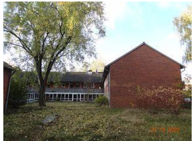
F 000 + 002: Gebäude 55a Außenansichten
