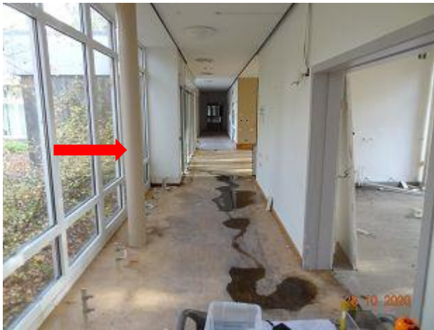
F 075 + 076: Geb. 55 T3 A, Bodenbelag + Kleber aus Flur, Probe P22 ( asbestfrei ) Rundstütze mit AZ- Schale MP 13
