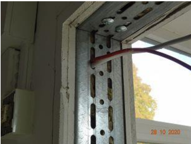
F 081: Leichtbauwände mit KMF
