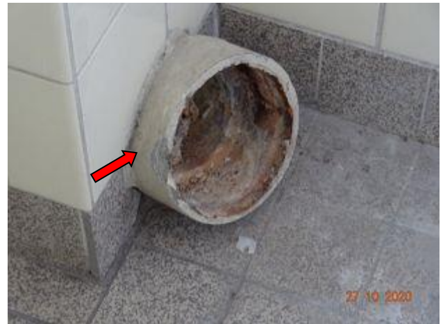
F 052 + 053: AZ- Abwasserrohre
