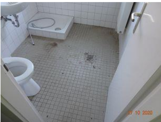
F 027 + 028: Geb. 55 A EG, Bodenfliesenkleber aus WC, Probe P8 ( Chrysotilasbest )
