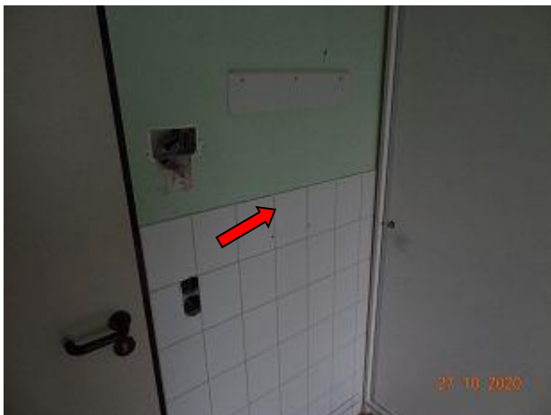
F 067: Geb. 55 T2 EG, Wandfliesenkleber aus R. 0.01, Probe P14 ( asbestfrei )
