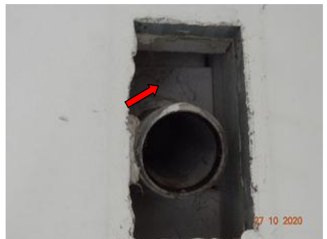
F 024 + 023: Eingemauerte AZ- Abluftkanäle
