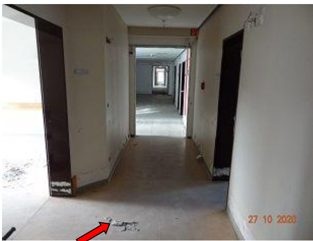
F 073 + 074: Geb. 55 T2, Bodenbelag + Kleber aus Flur, Probe P21 ( asbestfrei )
