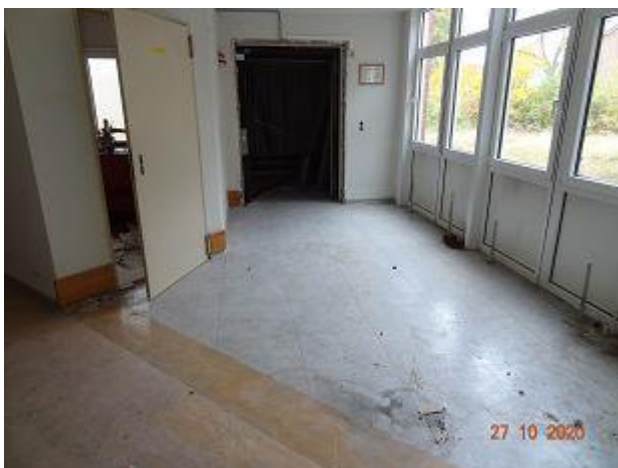
F 063 + 064: Geb. 55 T1 EG, Bodenbelag + Kleber aus Flur vor Fahrstuhl, Probe P12 ( asbestfrei )
