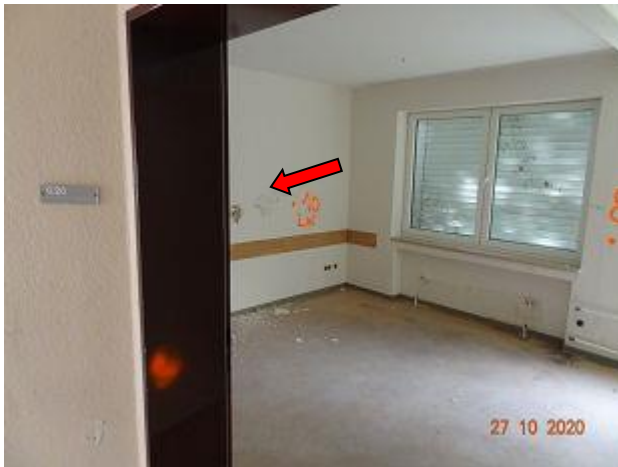
F 065 + 066: Styropor Dämmung in Leichtbauwänden aus R. 020, Probe P13
