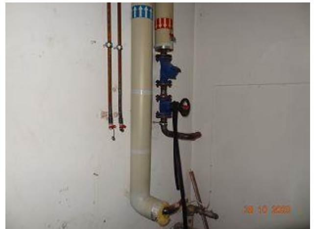
F 087: Rohrleitungen mit KMF
