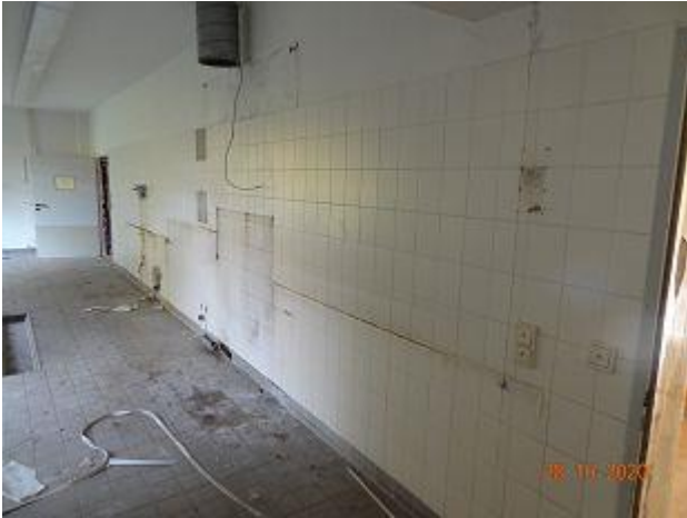
F 079: Geb. 55 T3 A + B, Wandfliesenkleber aus Hygienebereich, Probe P24 ( asbestfrei )
