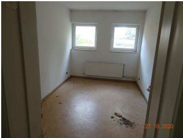
F 046 + 047: Geb. 55 T1 EG, Unter neuem Linobelag Floorflex Kleberückstände Probe P9 von Bodenbelag + Kleber ( Chrysotilasbest in schwarzer Anhaftung )
