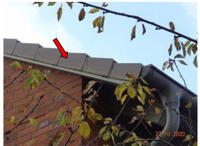
F 003 + 004: Giebel / Dachrandverkleidungen ggf. AZ
