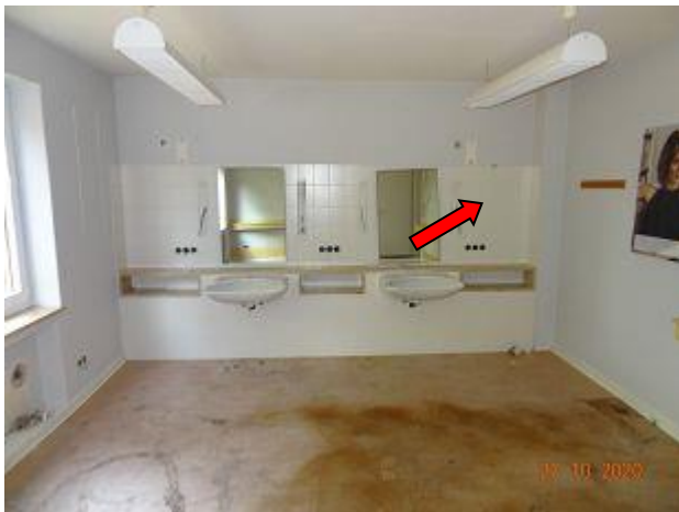
F 048 + 049: Geb. 55 T1 EG, Wandfliesenkleber, Probe P10 ( asbestfrei )
