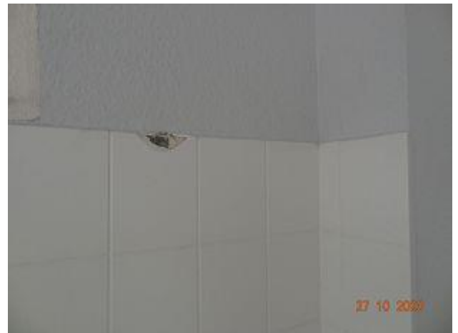
F 048 + 049: Geb. 55 T1 EG, Wandfliesenkleber, Probe P10 ( asbestfrei )
