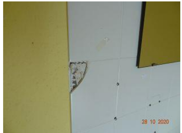
F 077 + 078: Geb. 55 T3 A + B, Wandfliesenkleber, Probe P23 ( asbestfrei )
