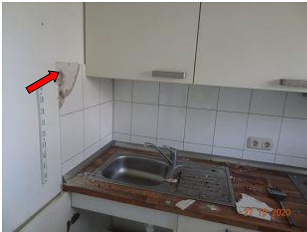
F 012: Geb. 55 A EG, Wandfliesenkleber aus Küche, Probe P3 ( asbestfrei )
