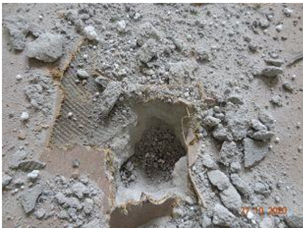
F 070: Styropor Trittschalldämmung, Probe P17
